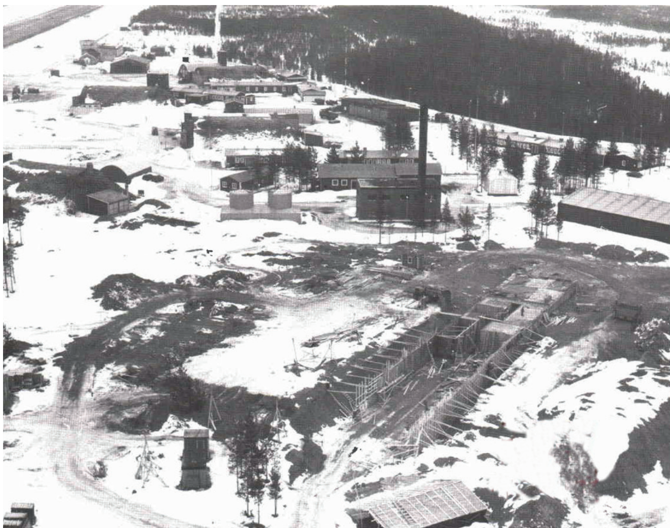
Översiktbild av RFN från 1976. I förgrunden håller man på med byggnadsarbeten till den blivande flygverkstaden. Längst upp till vänster ser man delar av startbanan. Svensk robotutveckling leder till en provplats i Norrland, som sedan blev RFN.
